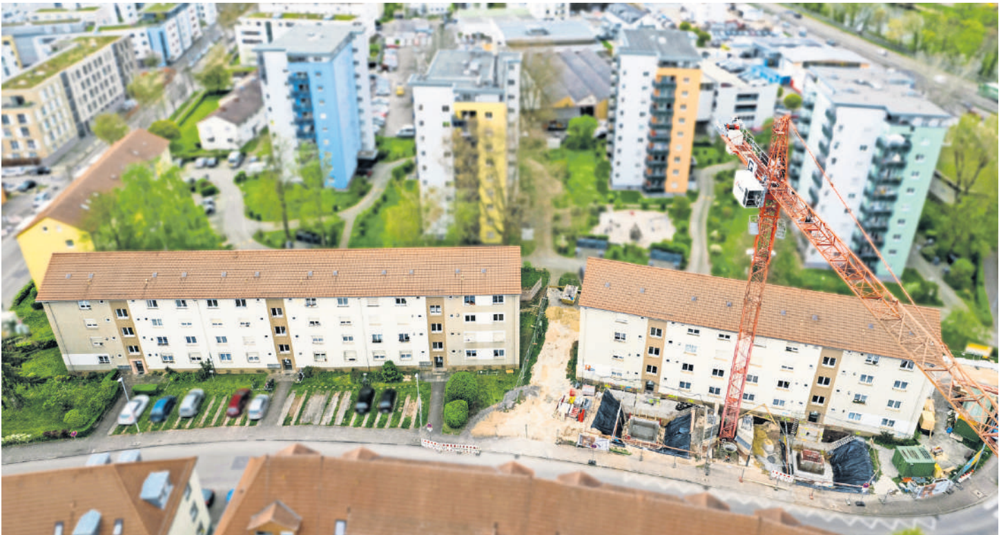
Die Gebäude in der Karl-Pfaff-Straße vor der Aufstockung.
