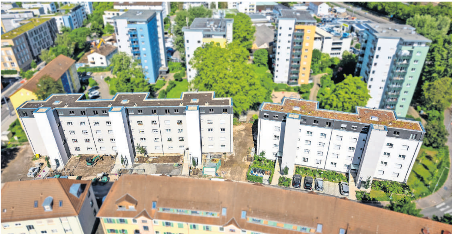
Neben der Erweiterung um ein Stockwerk in Holz-Hybrid-Bauweise haben die Mehrfamilienhäuser Aufzüge erhalten.
