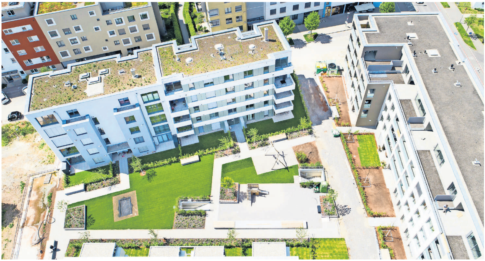
Das Quartier „Grüne Höfe“ macht seinem Namen alle Ehre. Wie hier im „Baufeld C“ gibt es überall viel Grün zwischen den Gebäuden.
